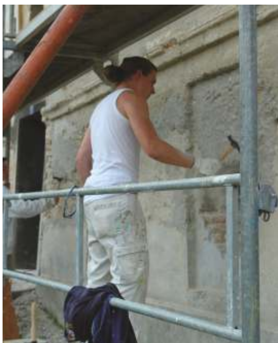
Der Zementputz an der Bauernhoffassade muss abgeschlagen werden
