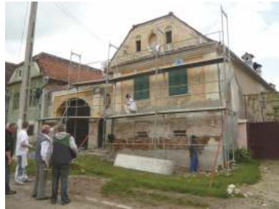
Eingerüstete Bauernhausfassade vor der Renovierung
