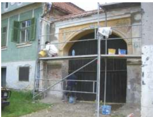
Maurer und Maler bei Verputzarbeiten an der Bauernhoffassade
