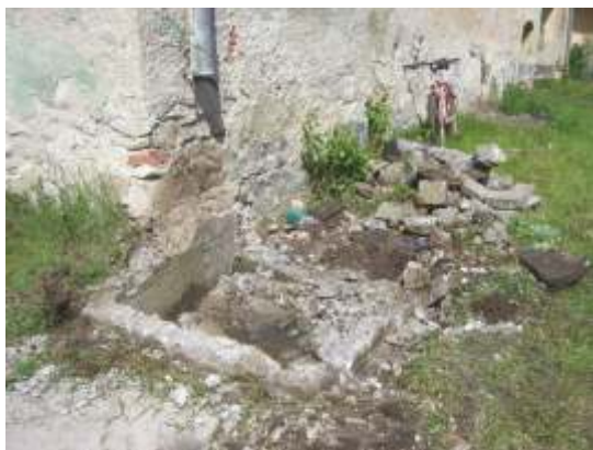
Die Reste der Zisterne werden bodengleich abgebrochen
