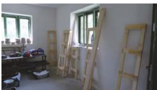
Die Seitenteile für die Regale in der Gemeindefeilsaalküche sind schon fertig
