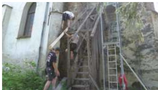
Der desolate Treppenaufgang mit Gerüst und ersten Vorbereitungsarbeiten
