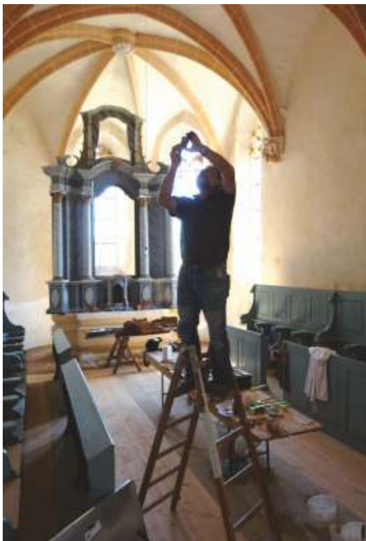
Begutachtung der Schäden in der Mardischer Kirche
