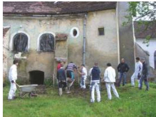
Die Maurer machen Probegrabungen an der Vorderseite des Pfarrhauses
