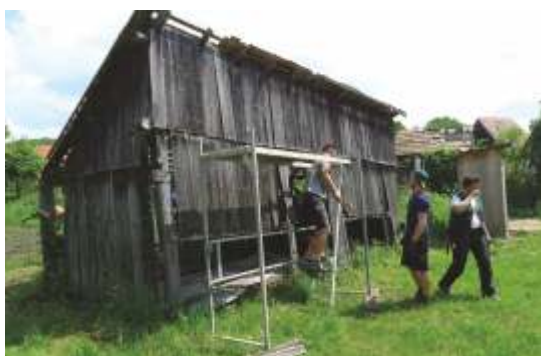
Der alte Holzschuppen wird abgetragen
