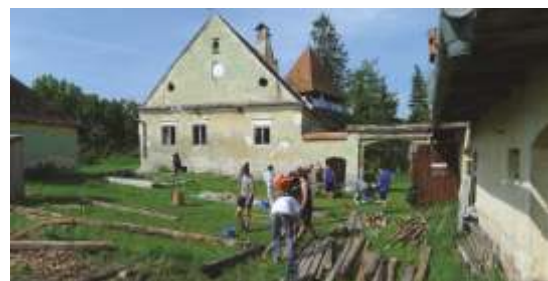
Die Zimmerer entscheiden, welches Holz noch weiterverwendbar ist
