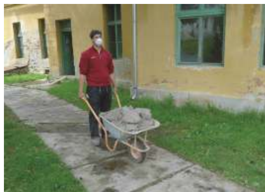
Abtransport der Reste des alten Schulhausbodens
