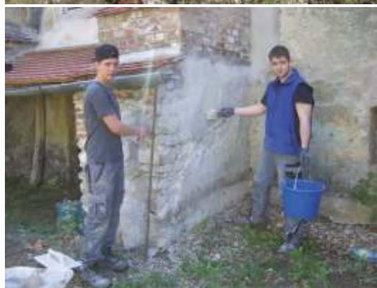
Verputzarbeiten / Stützpfiler am Pfarrhaus
