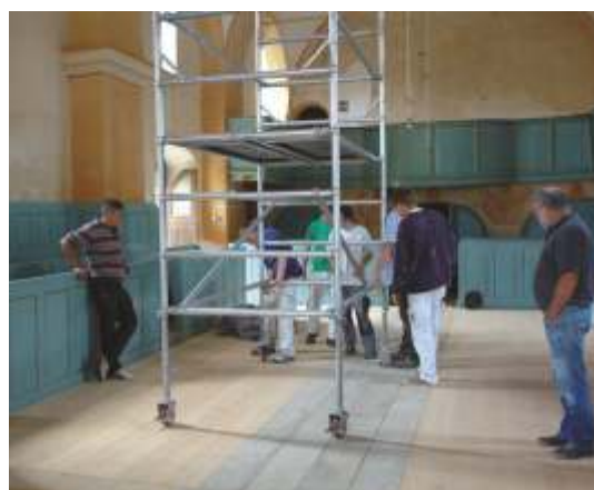
Maler und Zimmerer bauen das Innengerüst in der Kirche in Mardisch auf
