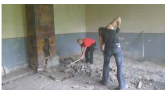
Eine staubige Angelegenheit – Ausheben des alten Erdbodens im Schulhausanbau
