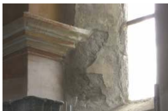
Hier muss viel verputzt werden ...
