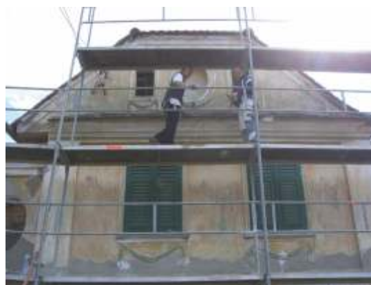
Zimmerer und Stuckateur an der Bauernhoffassade
