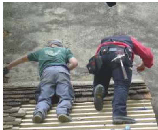
Die Überdachung am Treppenaufgang wird dank der Zimmerer allmählich wieder dicht
