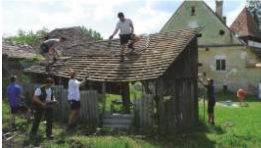
Beim Abdecken des Holzschuppens
