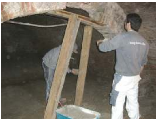
Bogen abstützen im Kellergewölbe
