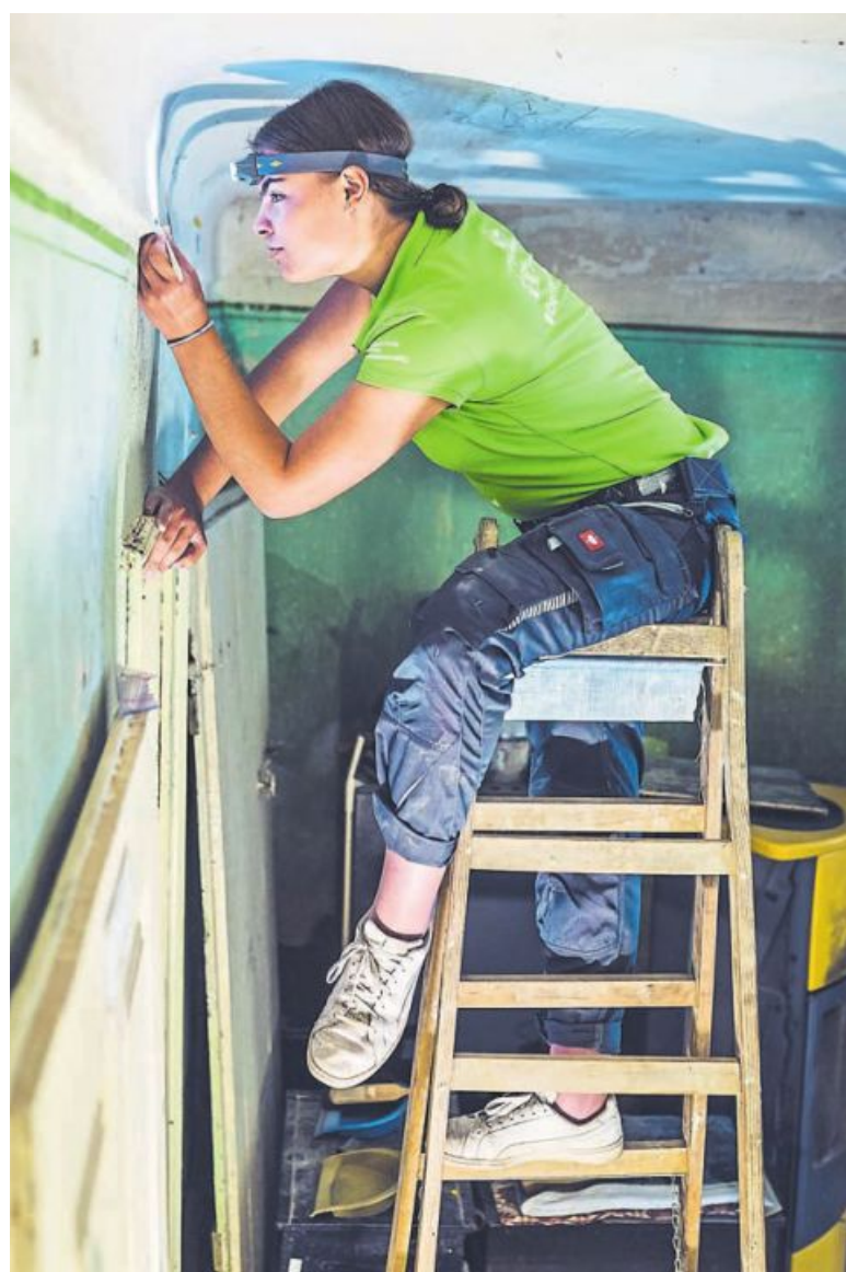
Bei der Befunduntersuchung im Pfarrhaus legen die Auszubildenden Putz- und Fassungsschichten in Briefmarkengröße frei. An manchen Stellen können sie 16 Schichten aus Kalkmörtel, Kalkschlamm und Leimfarbe bestimmen.
